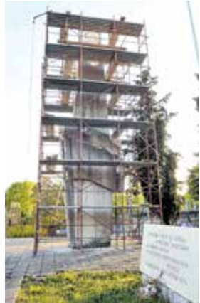
U obnovu će se uložiti 56.757,50 kuna
